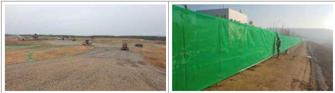
<보조운행로 및 비산방지망 설치>
