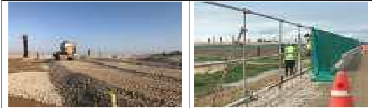
<보조운행로 및 비산방지망 설치>
