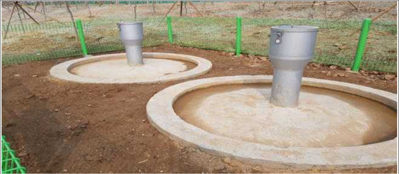
<그림 8.1> 지하수검사정 설치 사진
